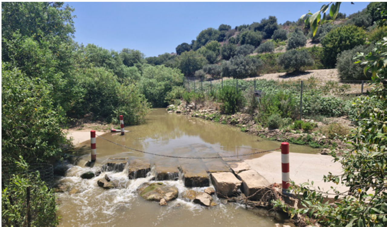
מעבר אירי משודרג במורד עין יבקע. המבנה נועד לאפשר מעבר חופשי של מים, סחף ואורגניזמים, אך בפועל קשה עקב סתימת חריצי המעבר והתפתחות מדרגת סחיפה במורד המבנה | צילום: אביב אבישר
