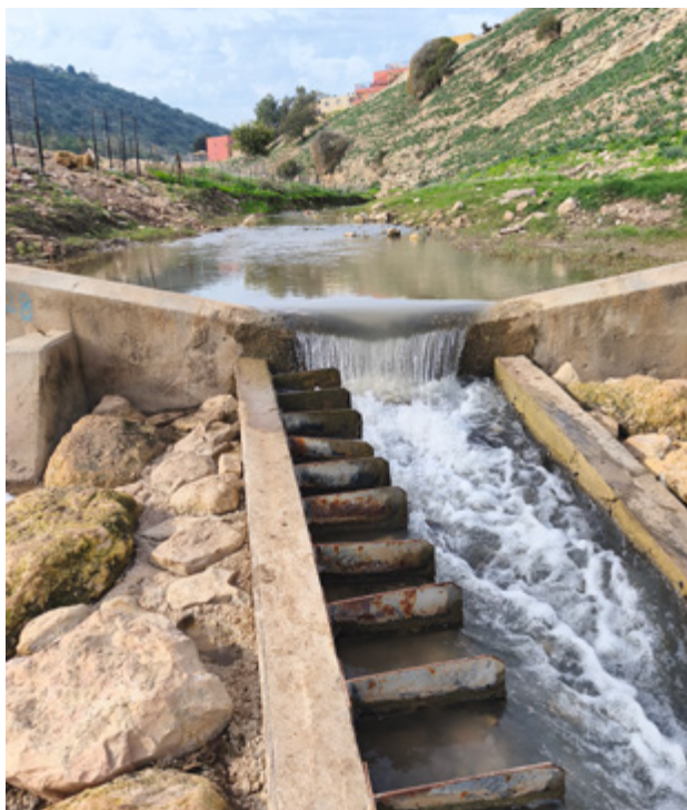
סולם דגים בתחנה ההידרומטרית 'עליל' בנפתול ראס עלי. ממצאי הניטור עולה כי הדגים משתמשים בסולם, אך עדיין לא מצליחים לשחות במעלה המפל. בימים אלה מתוכנן שדרוג נוסף לסולם הדגים | צילום: אביב אבישר
