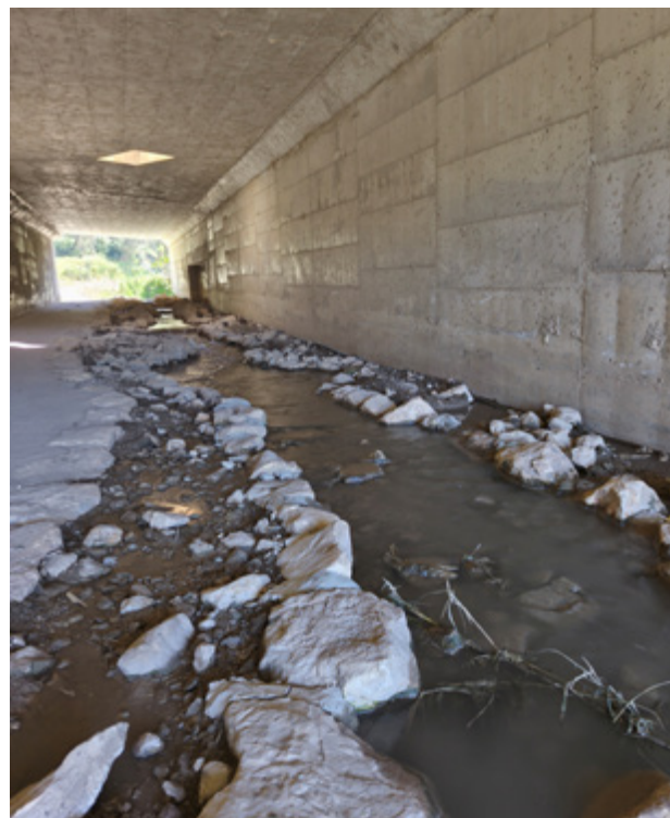
מעבר מים בוקס משוקם מתחת לכביש 79 באזור עינות ציפורי. הזרימה נאספה לאפיק משוחרר על גבי תכסית טבעית בשיפוע מתון | צילום: אביב אבישר
