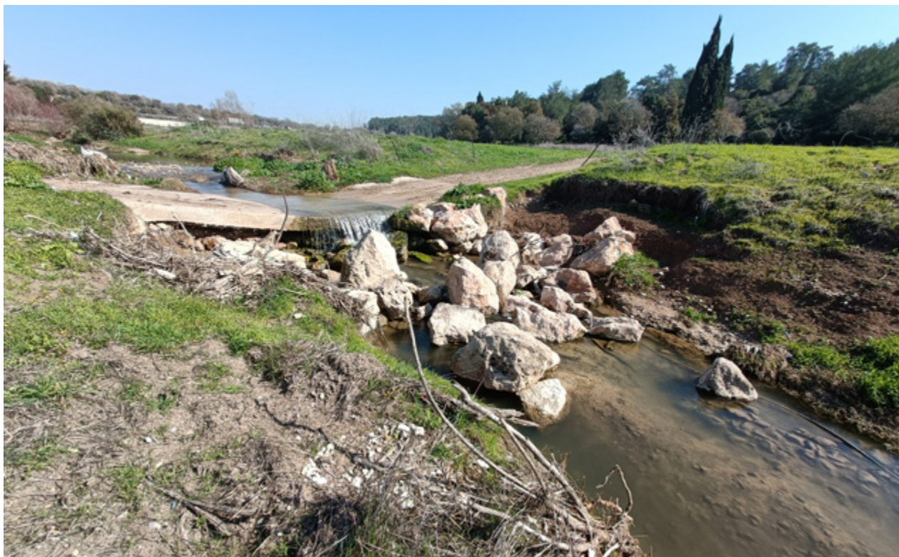
מעבר אירי שבמורדו נוצרו מדרגה ומפלון, ובעקבות זאת גם התחתרות עמוקה ואיציבות של הגדות. "אף שמעברים מסוג זה לרוב אינם חוסמים את זרימת המים, את תנועת הסחף או את מעבר החומר הצמחי, השפעתם על מורפולוגיית הערוץ ועל תהליכי ההתפתחות שלו משמעותית" | צילום: נועה הלל
