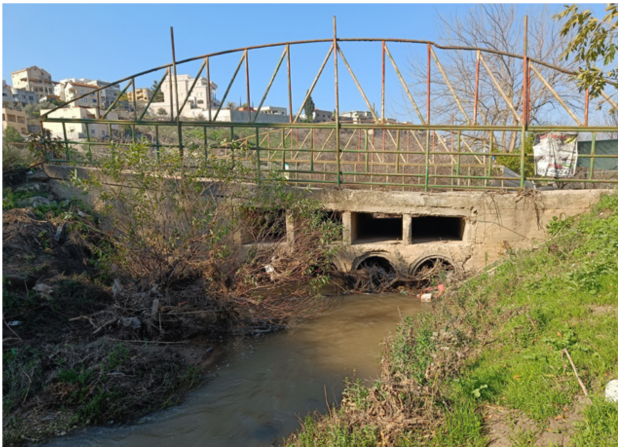
גשר הפוגע ברציפות המורפולוגית והאקולוגית של נחל ציפורי. הצניורות והתאים בגשר מצרים את הזרימה ומפריעים למעבר סחף וצמחייה דרכם. התוצאה היא התרחבות מקומית במעלה בשל הצטברות סחף וצמחייה, לצד האצת הזרימה, סחיפה והתחתרות במורד | צילום: נועה הלל
