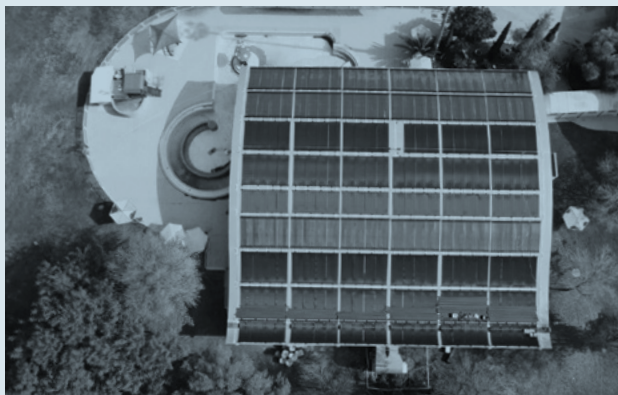
פרויקט תרמו-סולארי בפארק המים רעות. המערכת פועלת בטכנולוגיה ייחודית של חברת Fidelity Energy Consulting הישראלית, המבוססת על קולטי שמש המיוצרים במפעל של חברת מגן אקו-אנרג'י, בעוטף עזה. המערכת מתאימה למתקנים הזקוקים למים בטמפרטורות נמוכות-בינוניות (20-45 מעלות), ויכולה לחסוך עד 30% מצריכת אנרגיית גז | באדיבות Fidelity Energy Consulting
