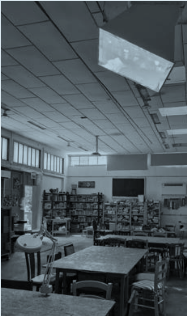
מערכת תאורה טבעית, של חברת סולייט, המותקנת בקיפוד – מרכז הקיימות של עיריית כפר סבא. המערכת מאפשרת הובלת אור שמש בעוצמה של כ־30,000 לומן לתוך המבנה בכל שעות היום, וכן מערכת שליטה המבטיחה שמערכת התאורה הטבעית תמיד תהיה מקור האור העיקרי במבנה, וכך מאפשרת התייעלות מרבית בצריכת אנרגיה | צילום: שלומית קיטרו
