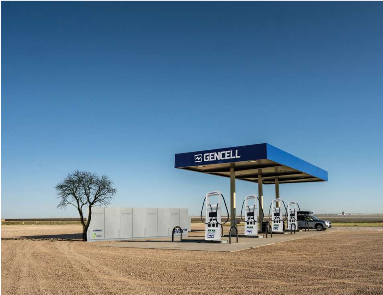
חברת גנסל הישראלית השיקה לאחרונה מערכת לטעינת כלי רכב חשמליים ללא תלות בחיבור לרשת החשמל (EVOX). הטכנולוגיה שפיתחה החברה מבוססת על תא דלק מימן | באדיבות חברת גנסל
