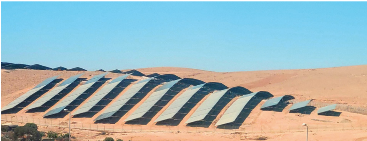
מתקנים פוטו-וולטאיים ביישוב אבו קרינאת, הסמוך לדימונה. המתקן מיועד לייצר הספק של 10–16 מגה-ואט. המתקן הוקם בהשקעת חברת RES. קו החשמל להובלת האנרגיה למערכת הארצית יתוכנן, יוקם ויופעל על-ידי חברת החשמל. עד אז המתקן אינו מייצר חשמל. צולם במסגרת סיור של מיום ע"ש ח"כ סעיד אלחירימי, בנושא אנרגיה סולארית בחברה הבדואית | צילום: שירה איתן
