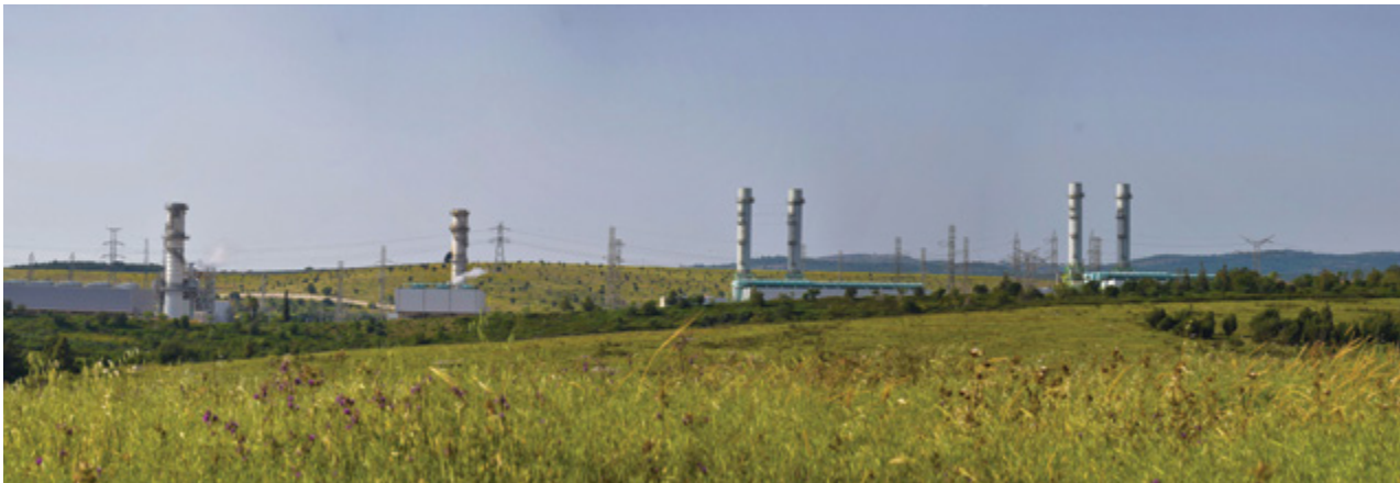
תחנת הכוח חגית, סמוך לצומת אליקים, המייצרת חשמל מגז טבעי. שימוש בקירור על־ידי אוויר, ולא על־ידי מי ים, מאפשר למקם לתחנות כוח גם בפנים הארץ | צילום: גל לליב, ויקימדיה, CC BY-SA 4.0
