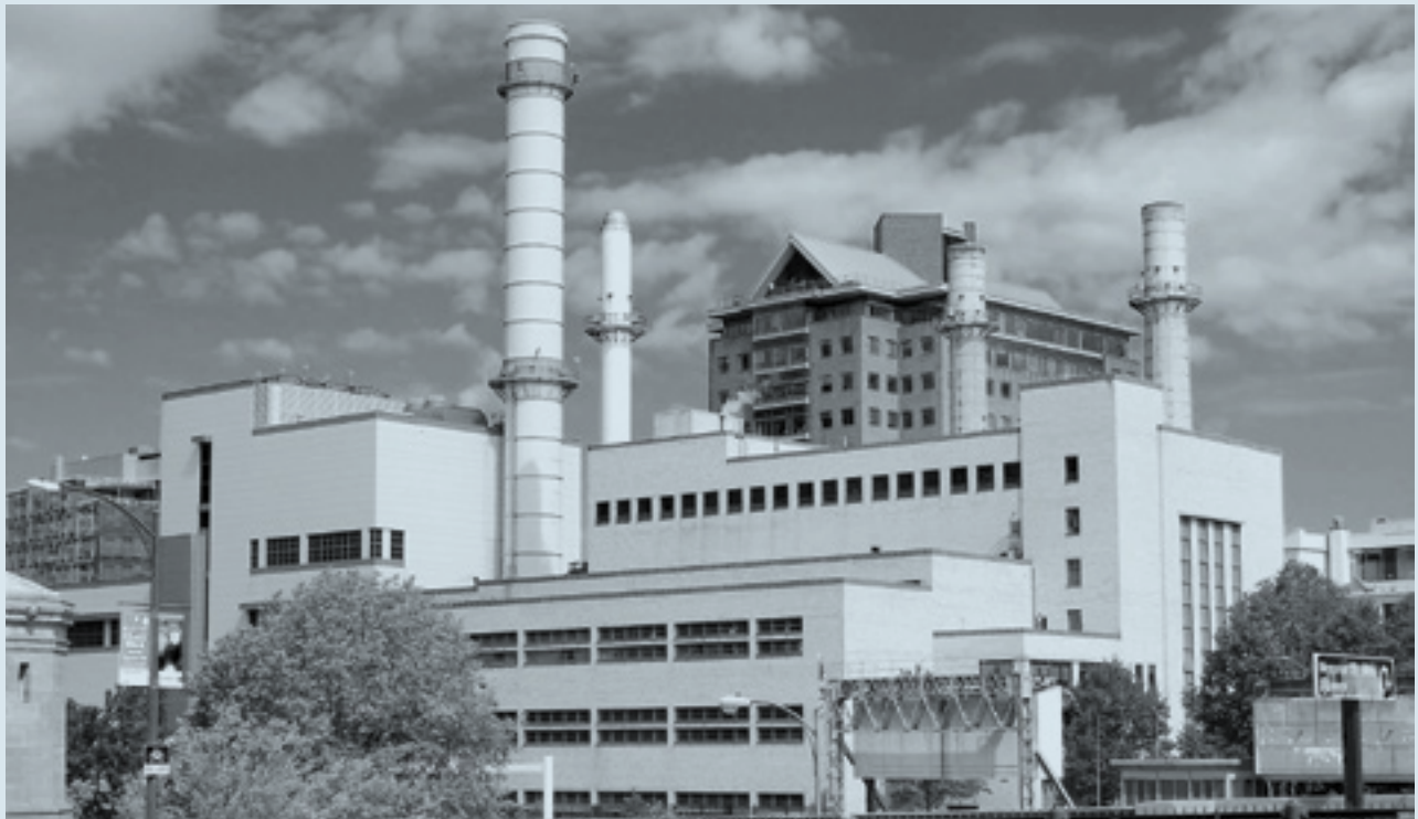
מתקן לייצור משולב של חשמל וחום, בהספק של כ-250 מגהוואט, בעיר קיימברידג' (מסצ'וסטס) | צילום: Fletcher6, Wikimedia, CC BY-SA 3.0
