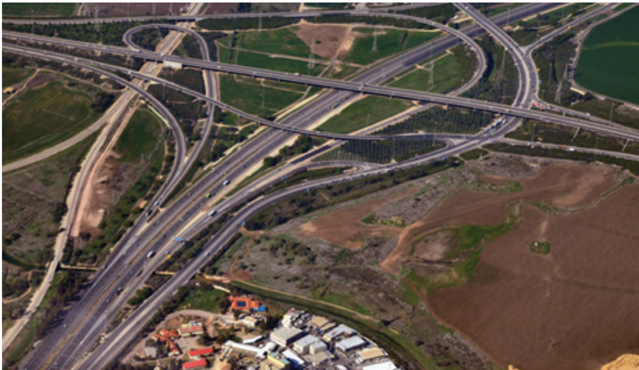
מרינוב: "לאורך 200 ק"מ של כביש חוצה ישראל אין אדם אחד שנפגע ממנו מבחינת רעש וזיהום אוויר. חברת כביש חוצה ישראל שיקמה מחצבות, הקימה מכוני סיהור שפכים, מנהרות ומעברים עיליים. התהליך שצריך לעבור כיום לפני סלילת כביש מורכב מאוד, ולעיתים אף מופרז" | צילום: דביר רז, ויקימדיה, CC BY-SA 3.0
