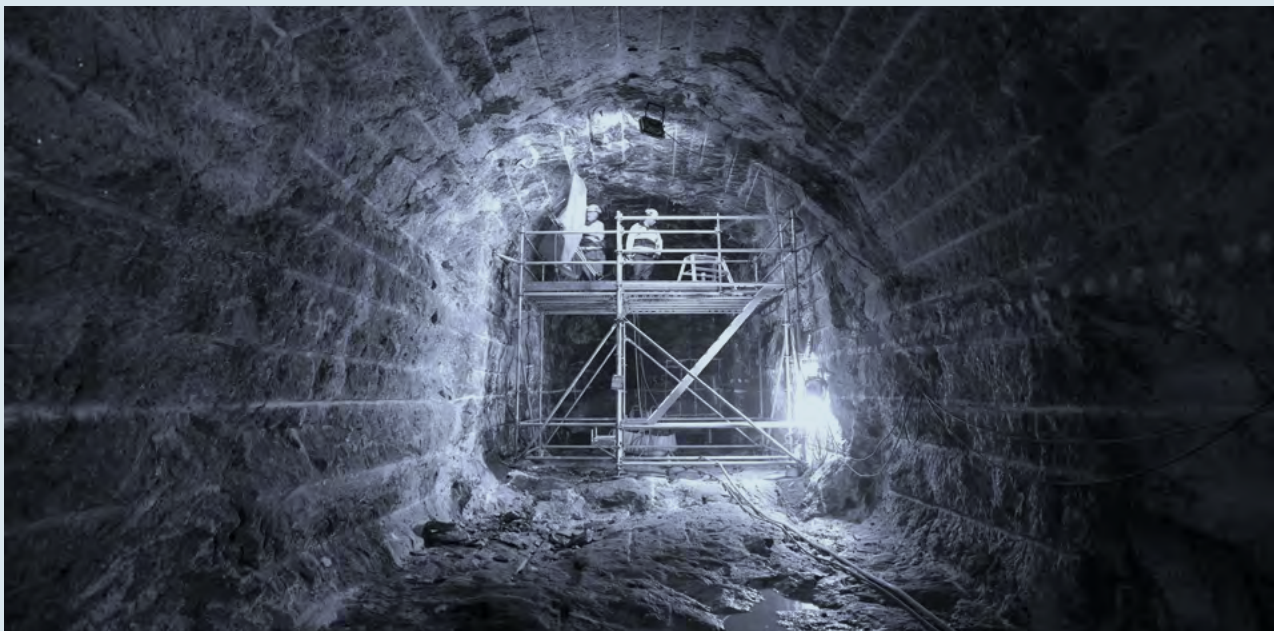
כריית מנהרה במתקן הראשון מסוגו לאחסון ארוך טווח של פסולת גרעינית. במתקן, שבפינלנד, ניתן לאחסן 6,500 טונות פסולת גרעינית בעומק של 450 מטר | צילום: Posiva Oy
