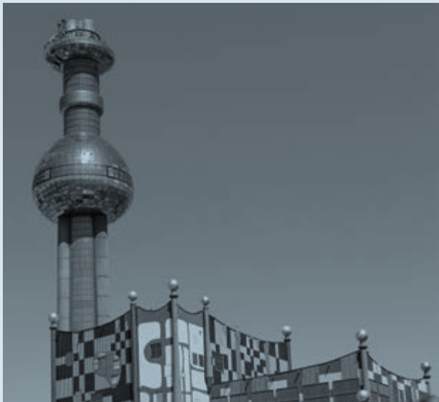
מתקן להשבת אנרגיה, בווינה, אוסטריה. המתקן מטפל בכ־250,000 טונות של פסולת ביתית מוצקה בשנה, מפיק חום עבור 60,000 בתי אב, ומייצר חשמל בהיקף תצרוכת של 50,000 בתי אב | באדיבות המתקן למחזור פסולת Spittelau
