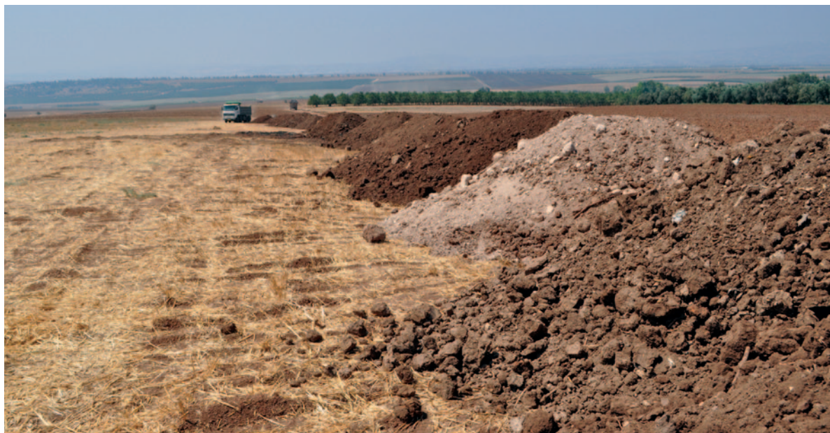
פיזור קרקע מעורפי כריית תוואי מסילת ירכבת העמק, בשטחים שהקרקע נסחפה בהם עד כדי חשיפת התשתית הסלעית | צילום: רמי זיידנברג
