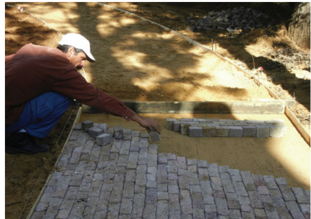
שימוש חוזר באבנים משתלבות. האבנים פורקו מגן סמוך ובוקעו ידנית, לטובת ריצוף שביל בגן מרים בגבעתיים | תכנון וצילום: ידקמה עירונית. ביצוע: שלמה כספי
