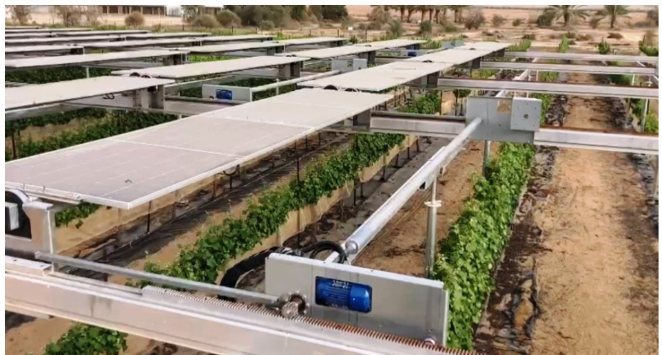
פאנלים סולאריים מתכוננים מעל כרם גפני יין. ניסוי בחקלאות אגרי-וולטאית שמבצעת חברת Agri-Light בשיתוף חברת EDF, המתקיים במו"פ רמת הנגב
