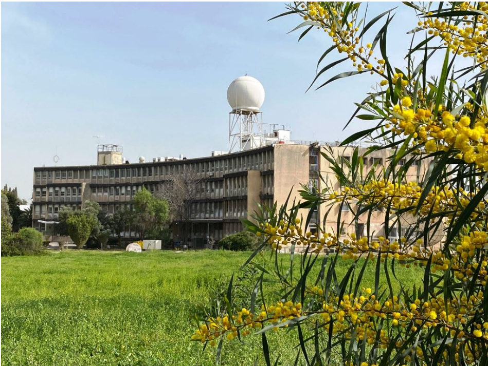
מכ"ם מזג אוויר על גג בניין השירות המטאורולוגי בבית דגן | צילום: ד"ר אייל אמיתי, באדיבות השירות
