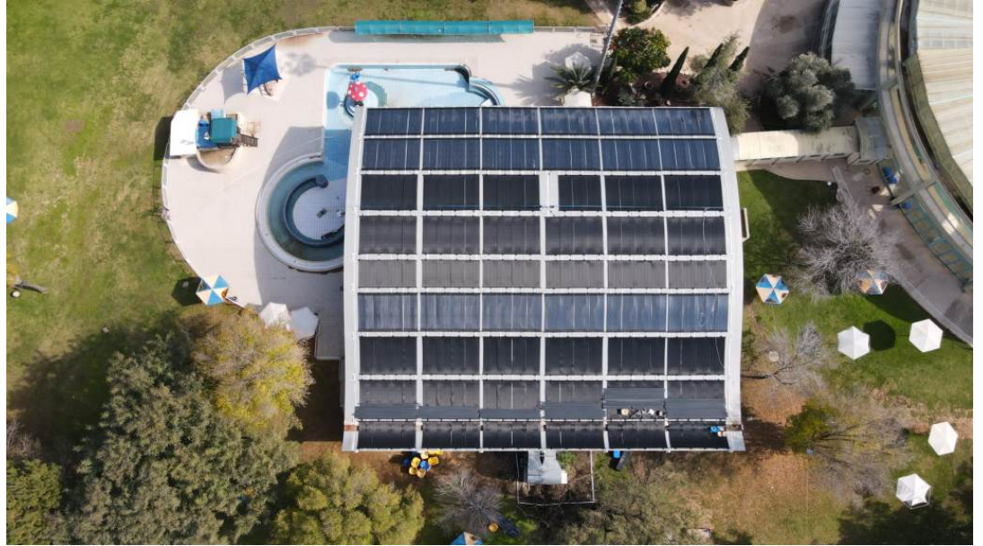
פרויקט תרמו-סולארי בפארק המים רעות. המערכת פועלת בטכנולוגיה ייחודית של חברת Fidelity Energy Consulting הישראלית, המבוססת על קולטי שמש המיוצרים במפעל של חברת מגן אקו-אנרג'י, בעוטף עזה. המערכת מתאימה למתקנים הזקוקים למים בטמפרטורות נמוכות-בינוניות (20-45 מעלות), ויכולה לחסוך עד 30% מצריכת אנרגיית גז | באדיבות Fidelity Energy Consulting
