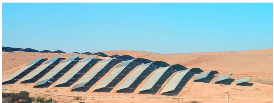
מתקנים פוטו-וולטאיים ביישוב אבו קרינאת, הסמוך לדימונה. המתקן מיועד לייצר הספק של 10–16 מגה-ואט.
