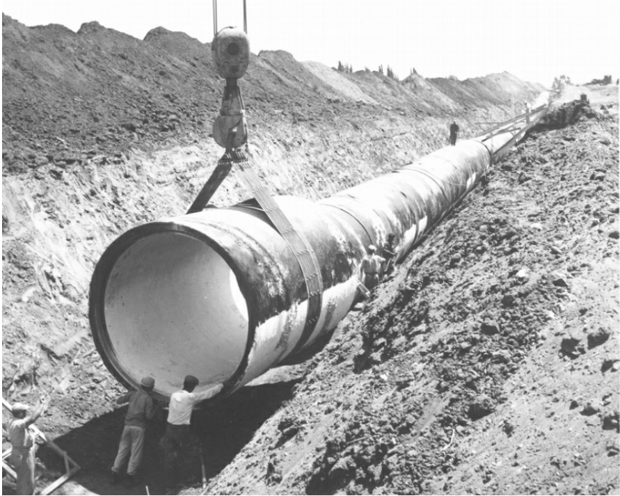
הנחת קטע מצינור המוביל הארצי סמוך לעילבון בשנת 1959 | באדיבות ארכיון הצילומים של קק"ל
