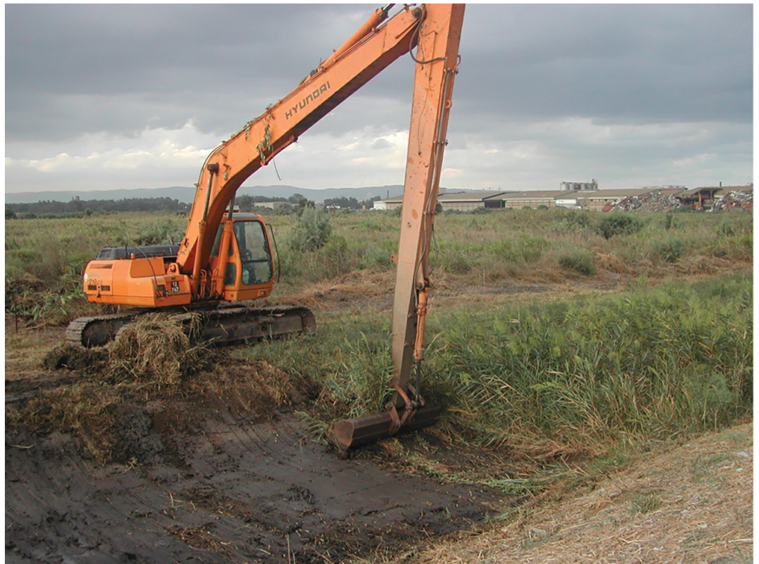
מקפיר (באגד) מפנה סחף קרקע וצמחייה מתעלה המתנקזת לנחל נעמן. הפינוי (כמו גם כיסוח הצמחייה) הוא פרקטיקת תחזוקה נפוצה, המבוצעת תדיר לפני החורף כדי לייצל את זרימת המים. הפינוי אומנם משפר את הניקוז בטווח הקצר, אולם פוגע בתפקוד האקולוגי | צילום: אמיר פרלברג
