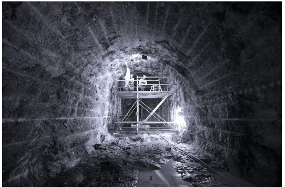
כריית מנהרה במתקן הראשון מסוגו לאחסון ארוך טווח של פסולת גרעינית. במתקן, שבפינלנד, ניתן לאחסן 6,500 טונות פסולת גרעינית בעומק של 450 מטר | צילום: Posiva Oy
