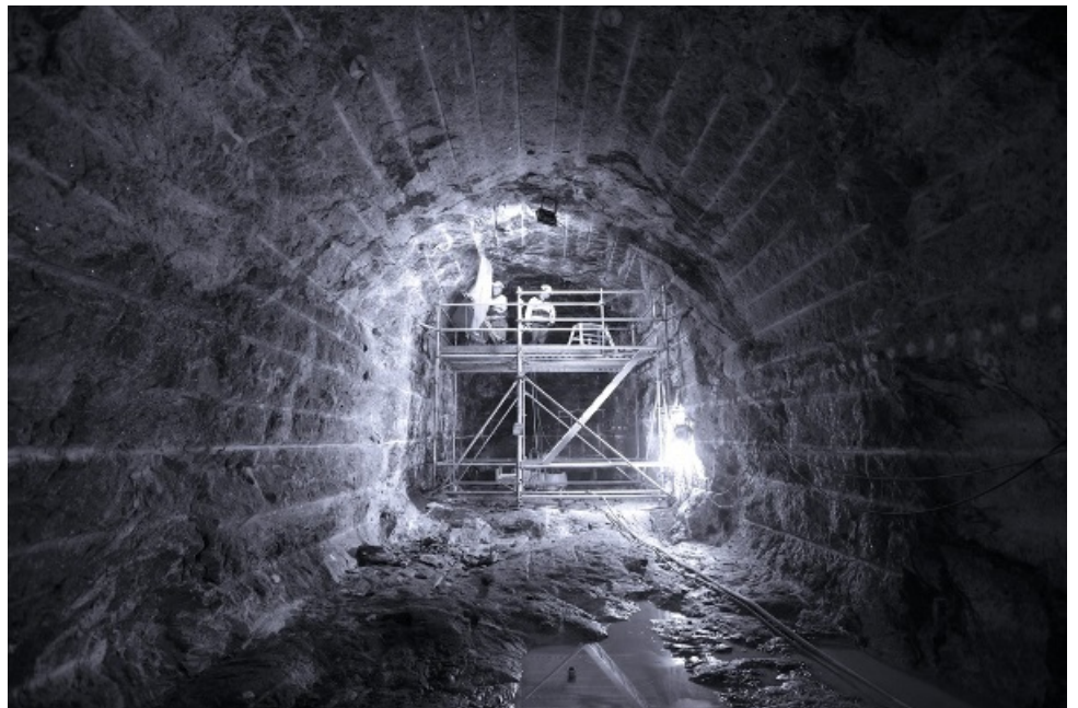
כריית מנהרה במתקן הראשון מסוגו לאחסון ארוך טווח של פסולת גרעינית. במתקן, שבפילנד, ניתן לאחסן 6,500 טונות פסולת גרעינית בעומק של 450 מטר | צילום: Posiva Oy
