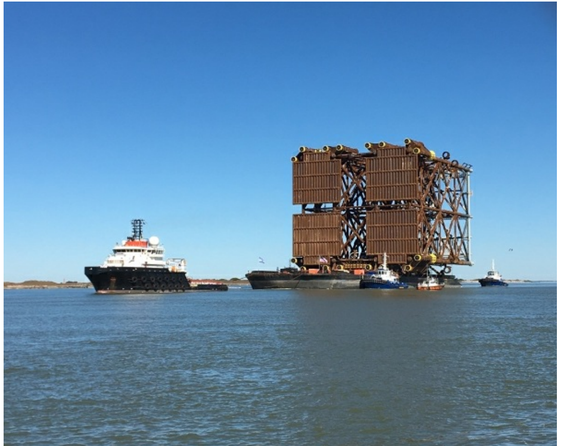
רגלי אסדת הטיפול בגז הטבעי שיופק בקידוח לווייתן, מושטות על גבי דוברות ענק, בדרכן ממפרץ מקסיקו. הן צפויות להגיע ארצה ברבעון הראשון של 2019 | באדיבות נובל אנרג'י
