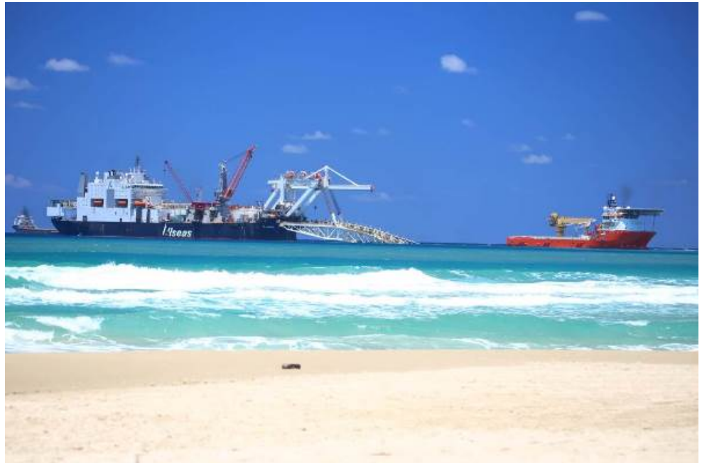
עבודות להנחת צינורות בקרקעית הים להובלת גז טבעי ותעבית (קונדנסט) סמוך לחוף דור, יולי 2018 | באדיבות 'שומרי בית'
