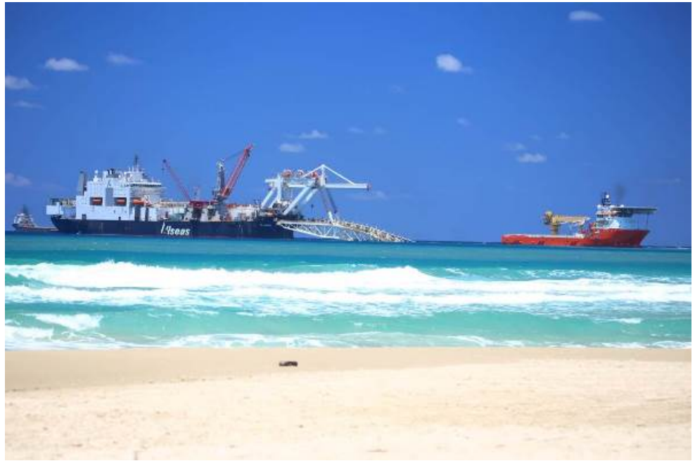
עבודות להנחת צינורות בקרקעית הים להובלת גז טבעי ותעבית (קונדנסט) סמוך לחוף דור, יולי 2018 | באדיבות 'שומרי הבית'
