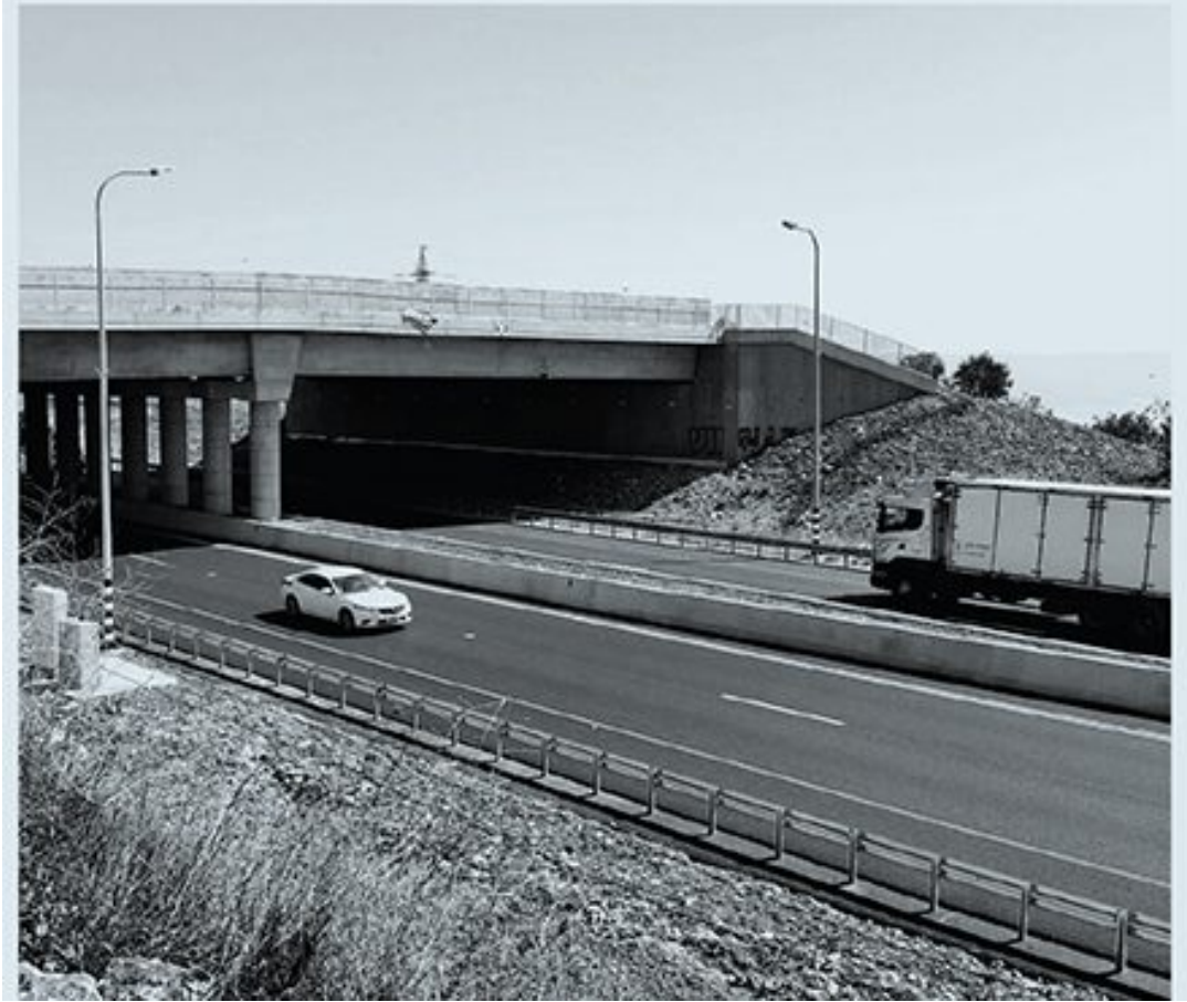
מעבר עילי מעל כביש 85 סמוך לצומת עמינד, שנועד ליצור נתיב מעבר במסדרון שנקטע עם סלילת הכביש והרחבתו | צילום: טליה אורון
