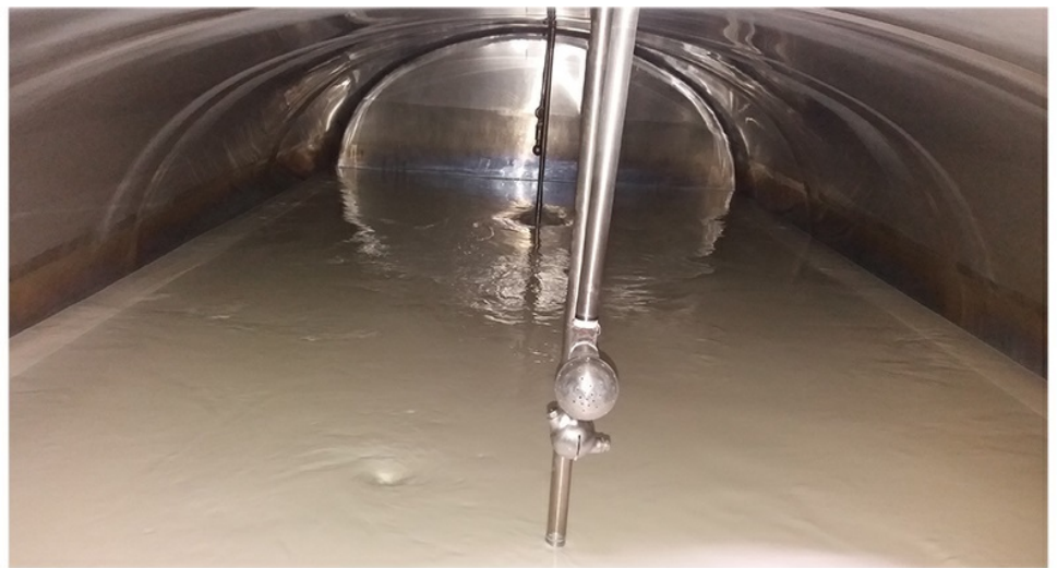
מכל חלב בנפח 24,000 ליטר לאכסון תפוקת רפת של 2-1 ימים, עד להובלתה למחלבה. רפת קיבוץ יזרעאל | צילום: שחר בוקמן
