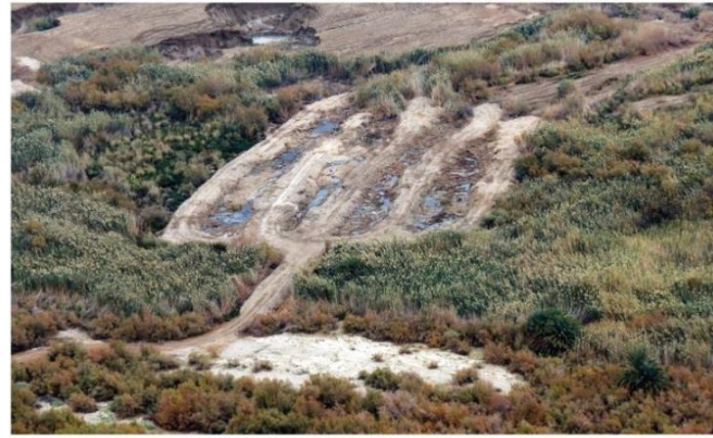
איור 2. ברכה 1 בשלבי הקמתה הברכה מולאה בחומר שמשמש בטיס ותמיכה לכלים מכניים, כדי שלא ישקעו בקרקע הבוצית | צילום: משה מינץ
