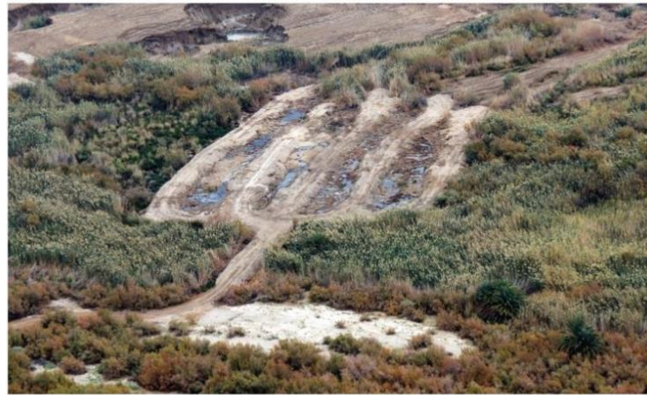
איור 2. ברכה 1 בשלבי הקמתה הברכה מולאה בחומר שמשמש בסיס ותמיכה לכלים מכניים, כדי שלא ישקעו בקרקע הבוצית | צילום: משה מינץ
