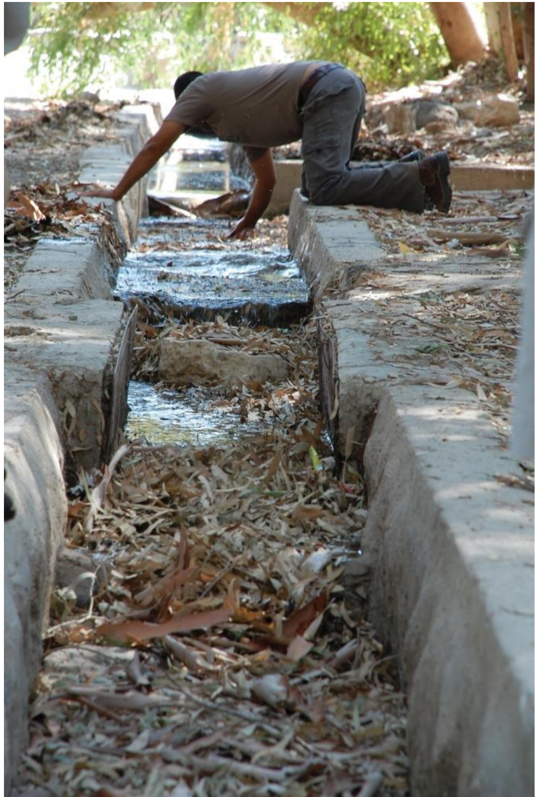
עין יזרעאל, המזין את נחל חרוד, סבל מהתייבשות לאורך תקופות ארוכות, בגלל ירידה במפלס מי התהום שמהם נובע המעיין. בתמונה: התחלת הזרמת מים מליחים מקידוח סמוך. מי הקידוח מוזרמים למעיין במקום השפיעה הטבעית, כהקצאת מים לטבע במסגרת חוק "זכות הטבע למים". 9.9.2014 | צילום: אביתר אסף
