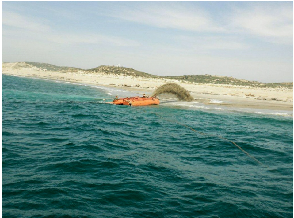
הזנת חוף מצפון לנמל אשדוד - ספינת מחפר מזרימה חול בצינור, והחול מותז לחוף. הבנייה לאורך החוף המפריעה להסעת החולות צפונה | צילום: גידי בטלהיים
