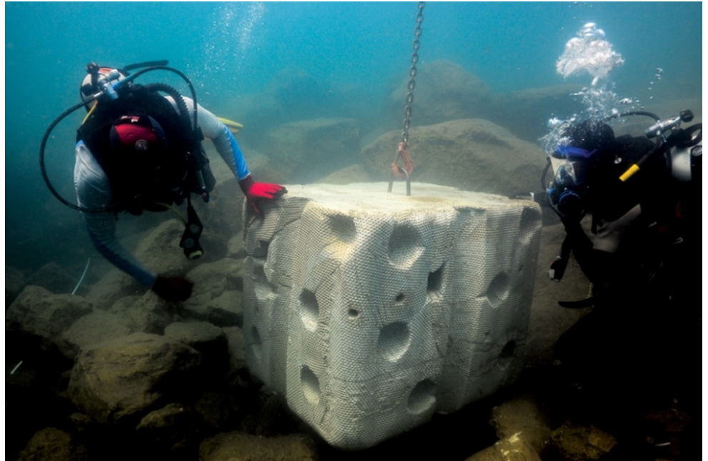
תמונה 1. הצבת 'אנטיפר אקולוגי' במימי מפרץ חיפה, במהלך העבודות להקמת הפולינום (האנגר ענק לצוללות חיל הים) | צילום: EConcrete Tech LTD
