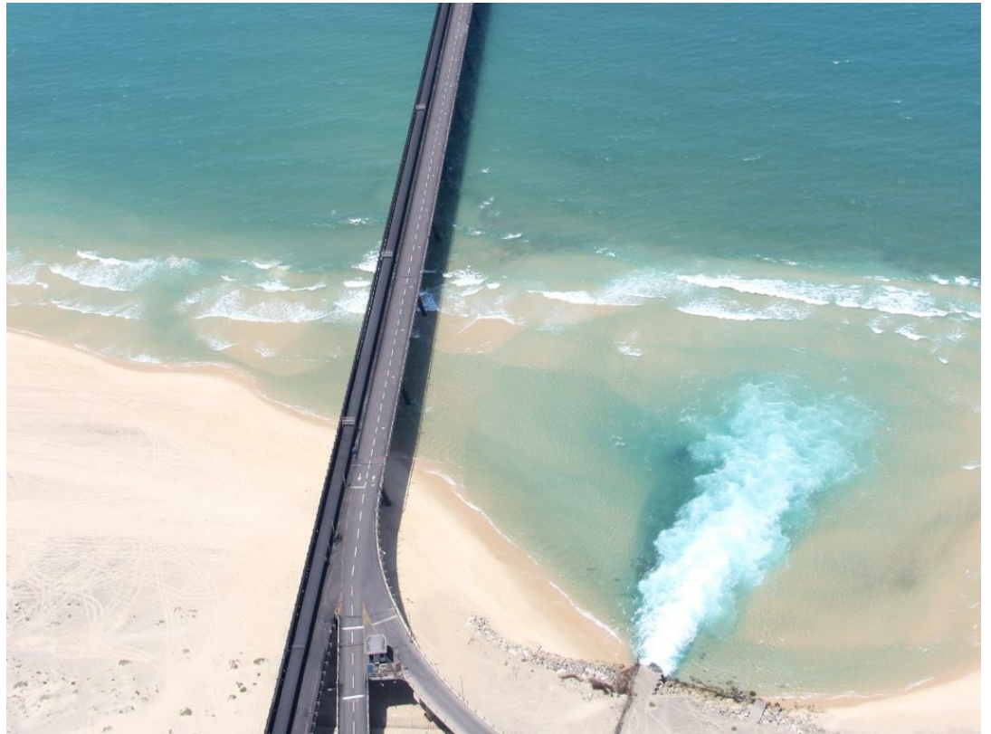
מזח הפחם ומוצא מי הקירור של תחנת הכוח רוטנברג באשקלון | צילום: אילן מלסטר
