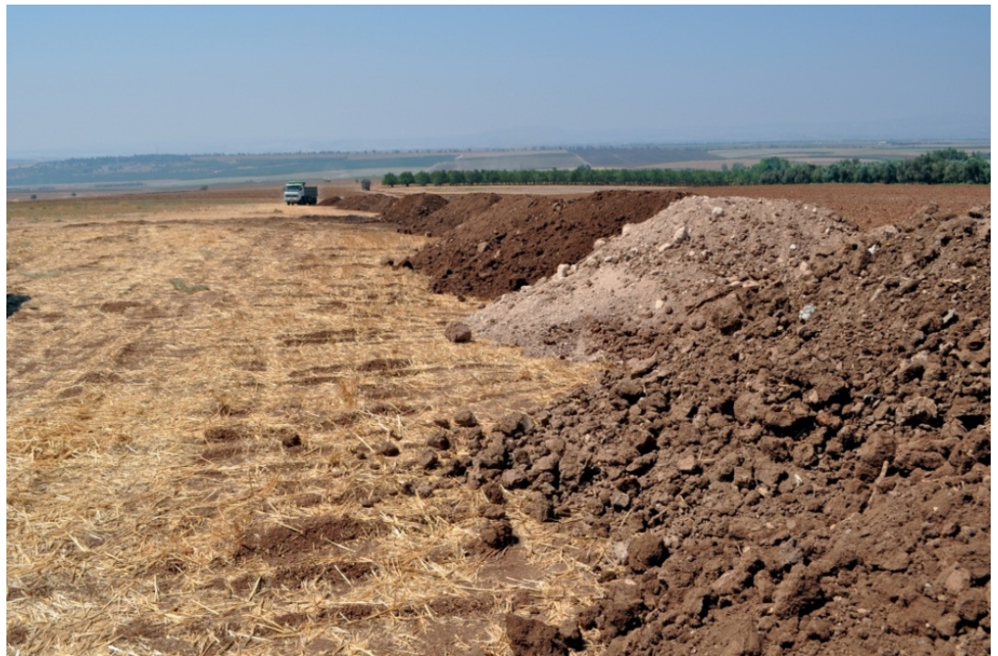
פיזור קרקע מעודפי כריית תוואי מסילת 'רכבת העמק' בשטחים שהקרקע נסחפה בהם עד כדי חשיפת התשתית הסלעית | צילום: רמי זיידנברג
