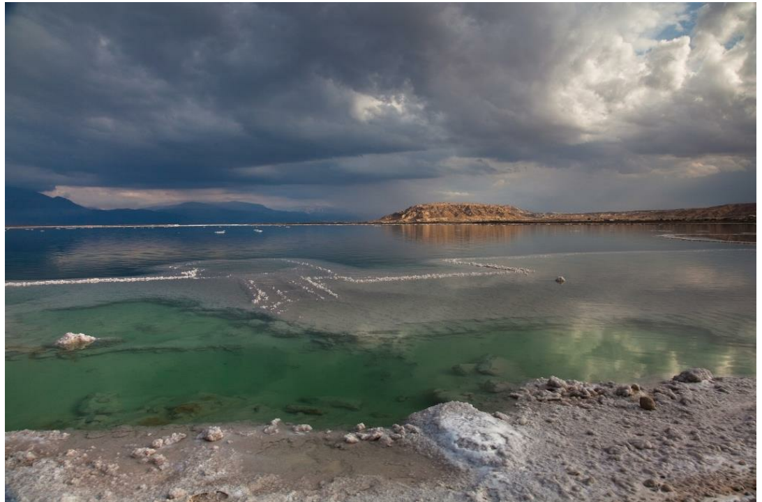
שקיעה מוגברת של מלח בקרקעית ברכות האידיו מקטינה את הנפח התפעולי של הברכות. מפעלי ים המלח מתמודדים עם הבעיה באמצעות הגבהת הסוללות ההיקפיות ומפלים הברכות התעשייתיות | צילום: דורון ניסים
