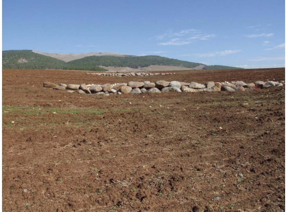
סכרים מאבן למניעת סחף קרקעות שהוצבו בשטחים חקלאיים במורדות הדרומיים של גבעת המורה | צילום: רמי זיידנברג
