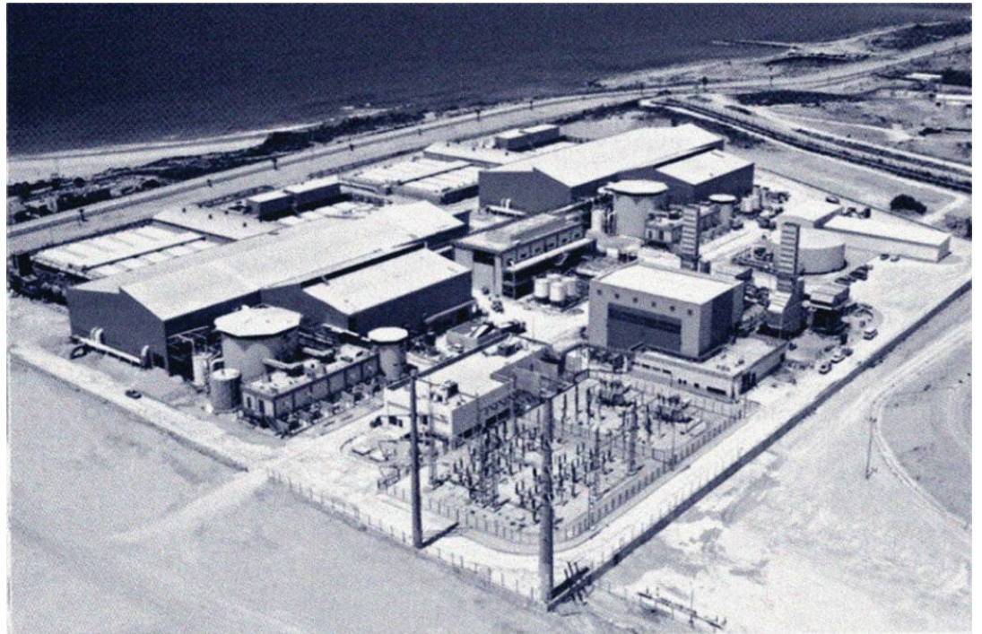
מתקן ההתפלה באשקלון מהגדולים מסוגו בעולם. באדיבות חברת IDE הנדסת התפלה לישראל
